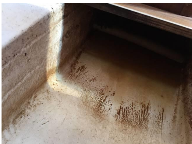
Sentina / strutture interne
