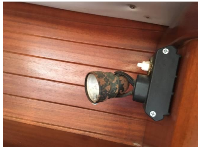
Corpi illuminanti arrugginiti e supporti danneggiati
