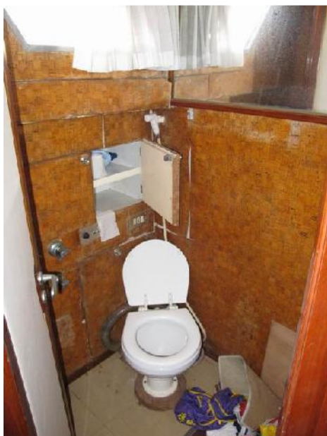
Foto 35 – Bagno di servizio: WC
