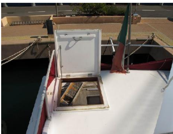
Foto 17 – Passo d'uomo di accesso al flying bridge
