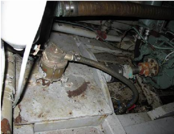
Foto 63 – Astuccio dell'asse dell'elica del motore di sinistra visto dal locale tecnico di poppa
