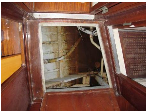
Foto 47 – Cabina armatore: altra botola
