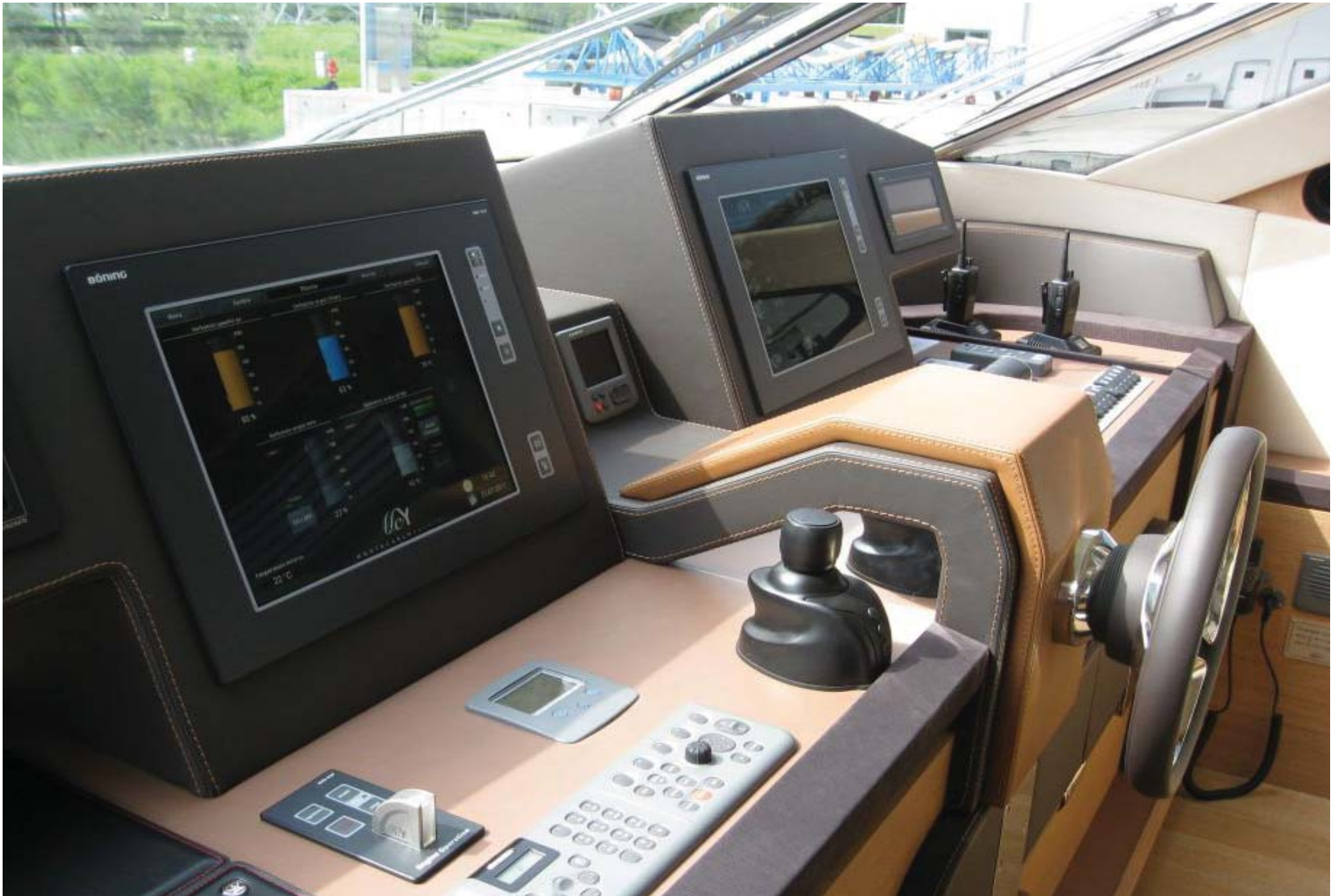
Stazione di comando - Pilot station
