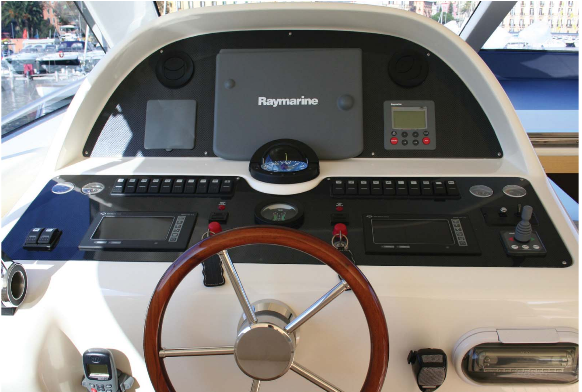
Stazione di comando - Pilot station
