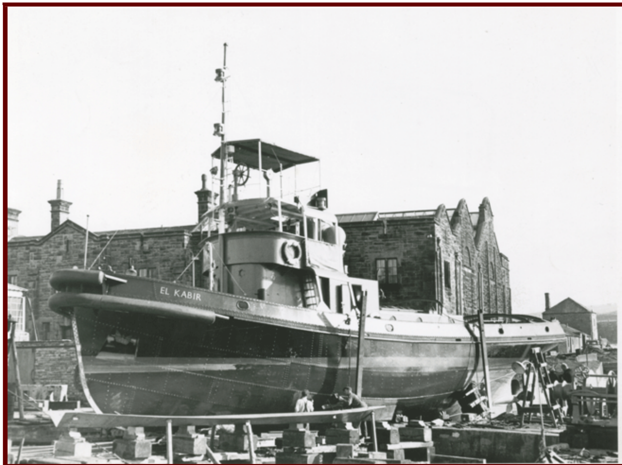
Ritocchi finali applicati in cantiere da parte dei lavoratori al rimorchiatore El Kabir costruito per il porto del Sudan nel 1957. Nota: lo scafo e il ponte rivettato elevati. Fairmile navi progettate costruite a Berwick vedrebbe throughout servizio del mondo. Foto: Inserzionista Berwick ©
