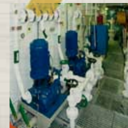
Vere sale machine su veri Explorer con tubazioni in acciaio zincato.
