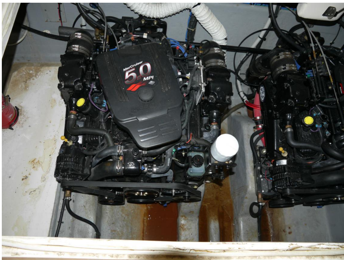
Vano motore con n° 2 motori Mercury da 194 Kw – Benzina
