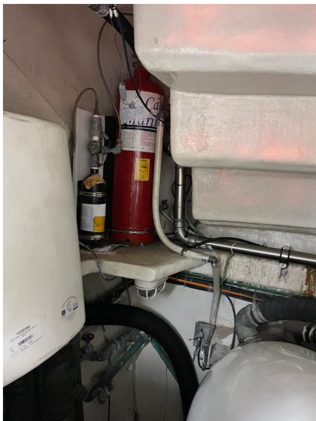
Sistema di estinzione incendio in apparato motore
