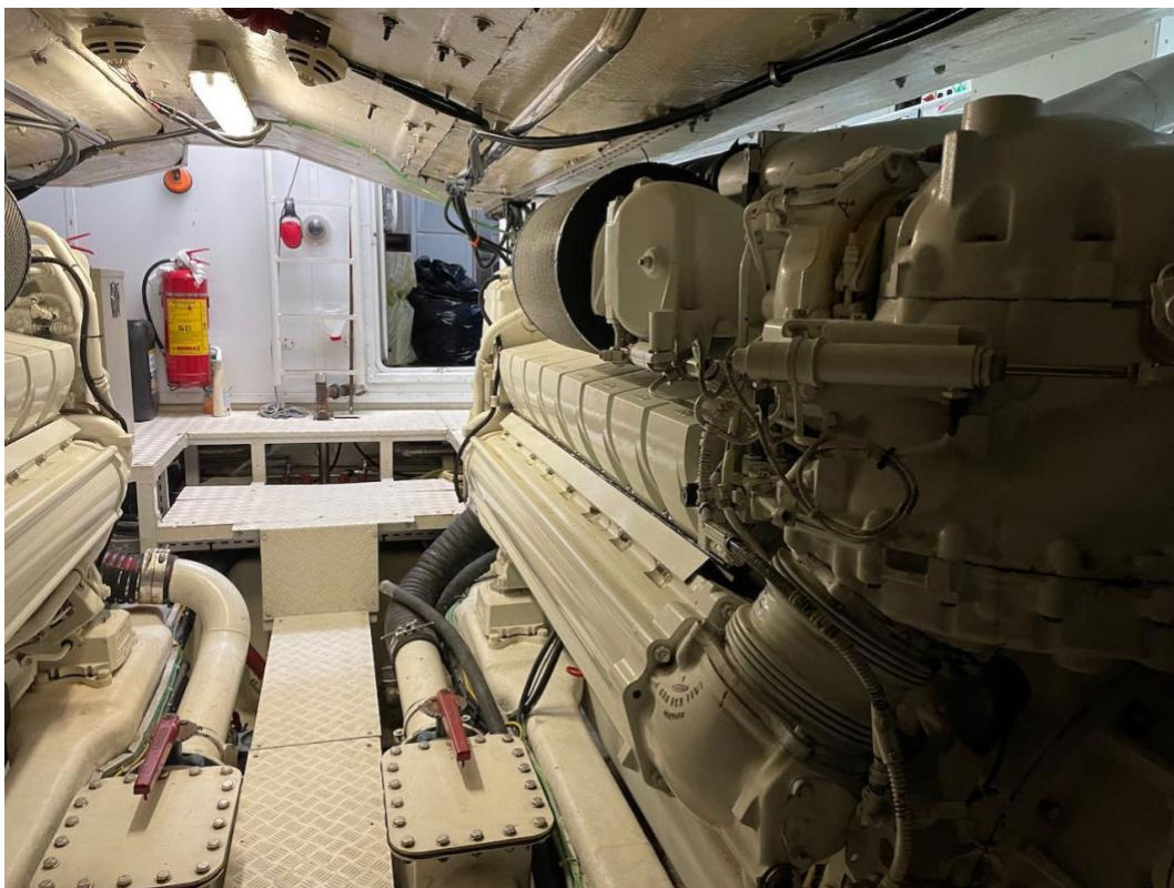
Locale apparato motore - motore di destra
