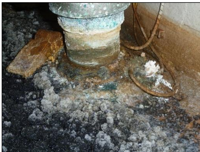
Photo 15 : corrosion importante
