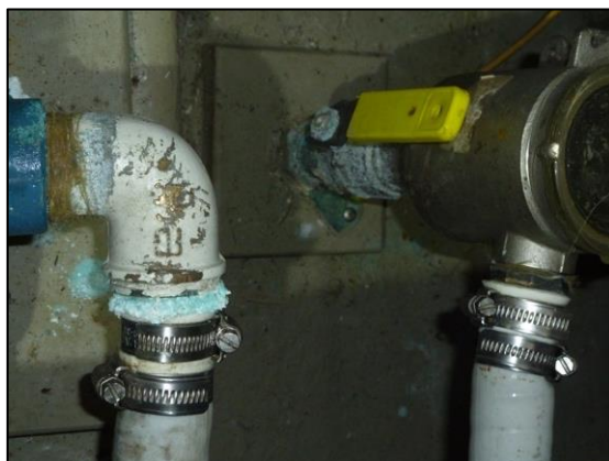
Photo 14 : corrosion
