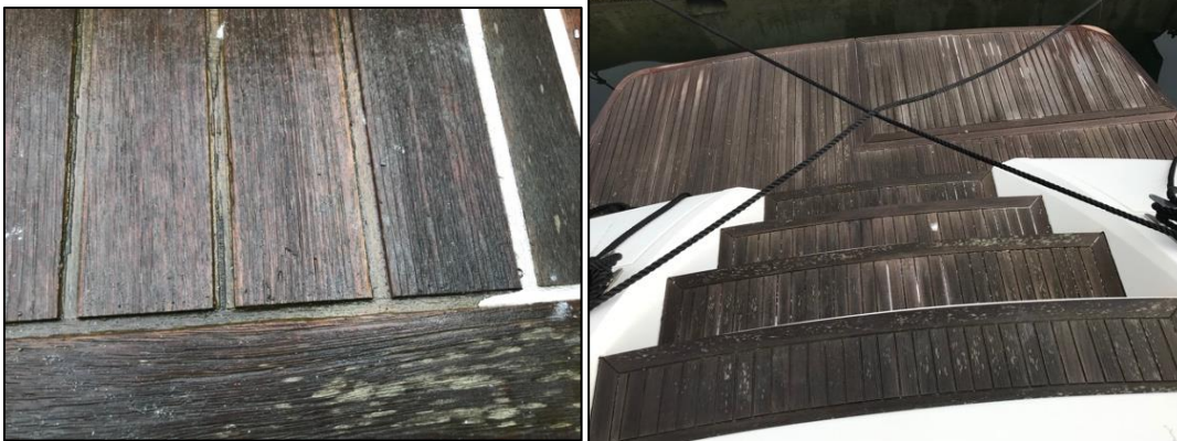
Photos 1, 2 : vues du revêtement en teck
