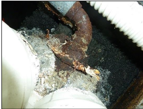
Photo 20 : corrosion
