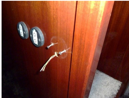
Photo 15 : manque interrupteur
