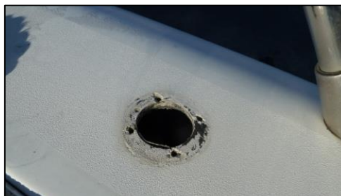
Photo 10 : support du taud de soleil manquant
