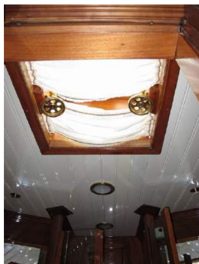
Foto 9.10 – Bagno armatore: cielino
