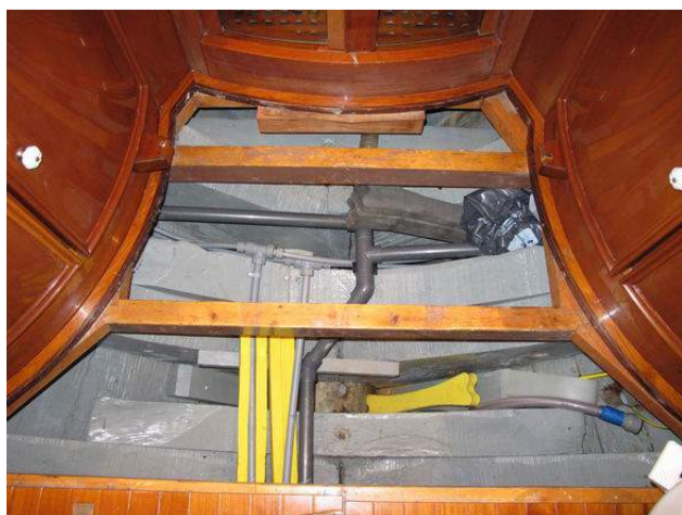
Foto 9.15 – Sentina sotto al pavimento del bagno armatore. Si possono notare le tubazioni dell'acqua in plastiva (sistema Acron) e quelle degli scarichi, anch'essi in plastiva
