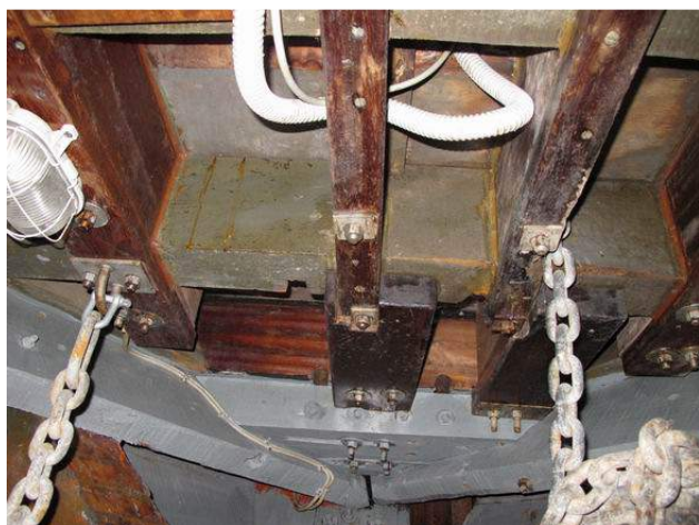
Foto 9.13 – Gavone di prua: rinforzi del ponte con attacchi dell'estremità delle catene
