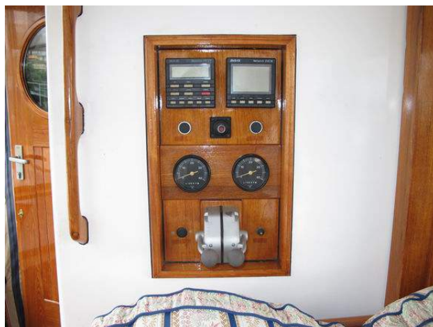
Foto 6.4 – Pozzetto: particolare ripetizione posto di manovra
