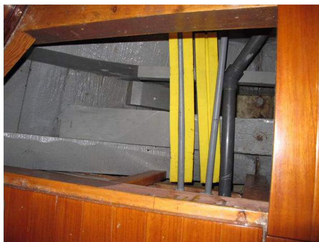
Foto 9.16 – Particolare dell'attacco di un madiere del fondo alla costola del fianco
