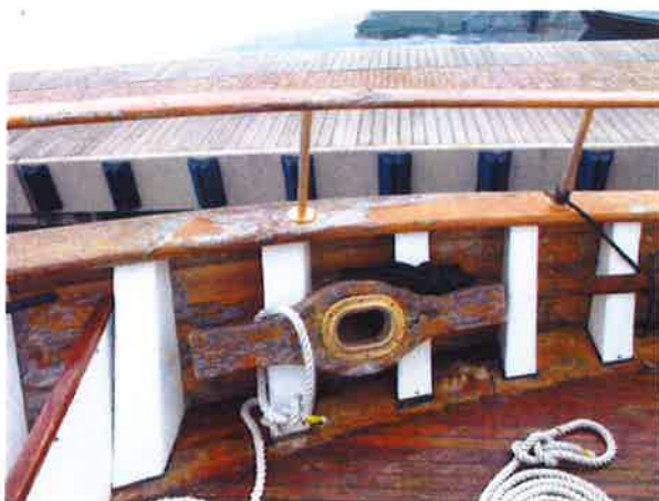
Foto 6.11 – Prua: passacavi lato di dritta
