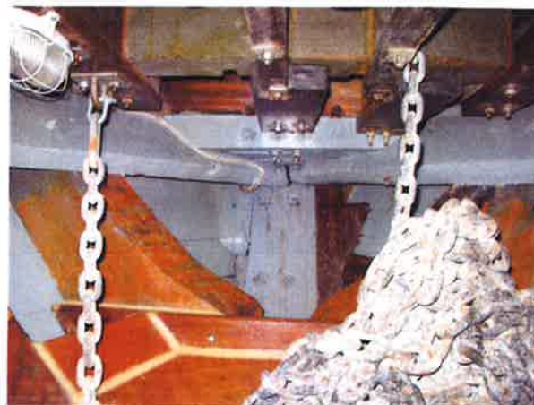
Foto 9.12 – Gavone di prua: pozzo catene
