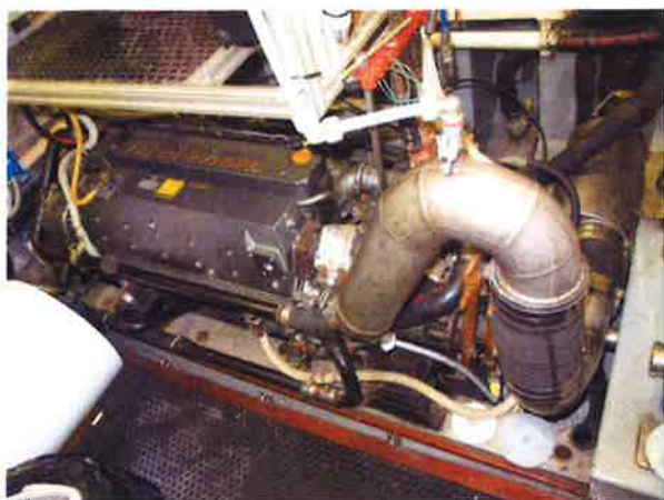
Foto 10.5 – Sala macchine: motore di dritta
