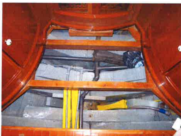
Foto 9.15 – Sentina sotto al pavimento del bagno armatore. Si possono notare le tubazioni dell'acqua in plastiva (sistema Acron) e quelle degli scarichi, anch'essi in plastica
