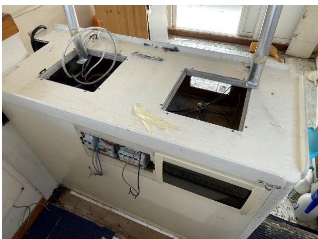
Attrezzature elettroniche mancanti
