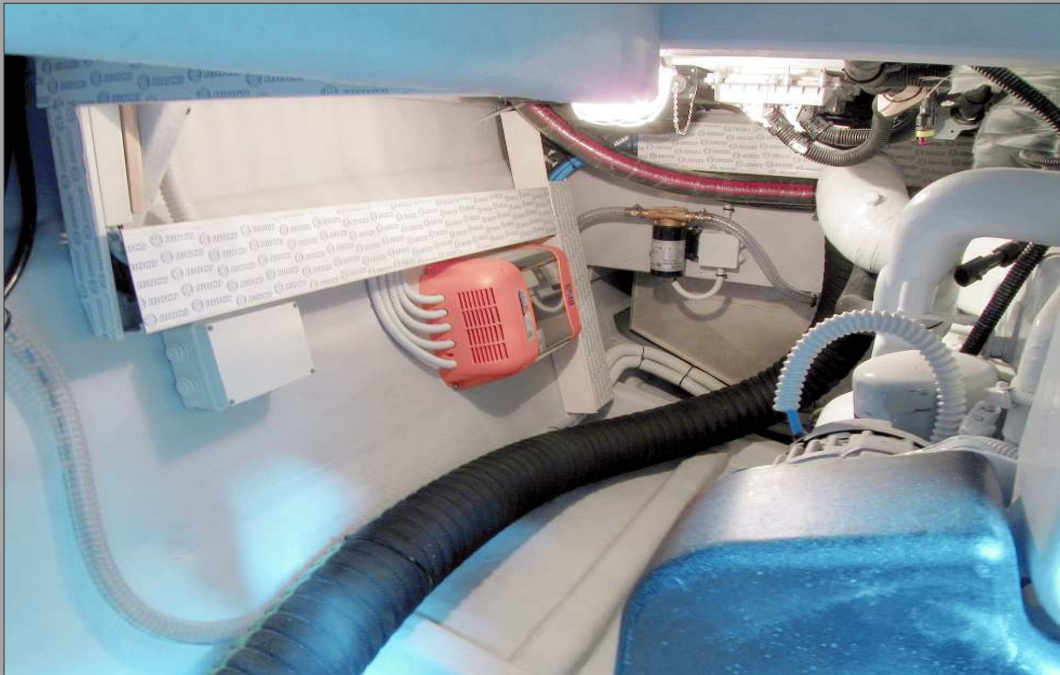
Sala macchine: grandi spazi a disposizione, impianto elettrico in regolari canaline
