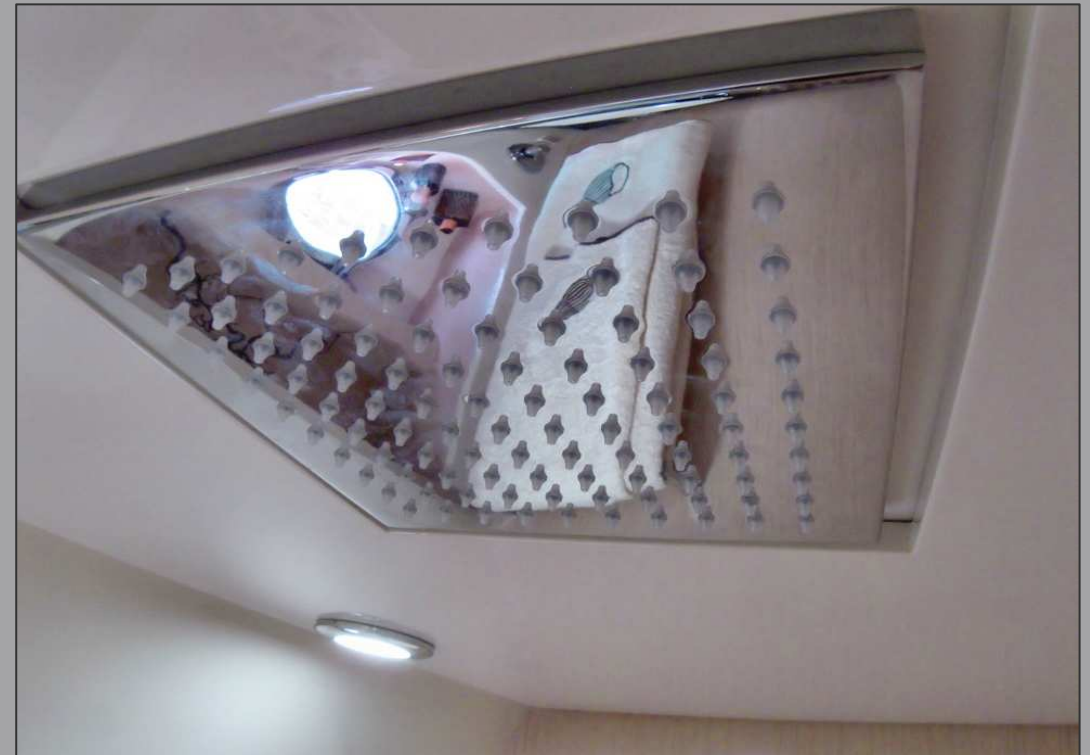
Diffusore doccia a plafone con illuminazione acqua in uscita
